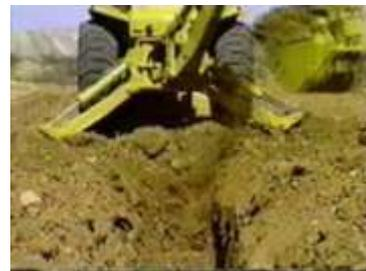
Una vez limpia la zanja mantenga el cucharón lo más bajo posible, vacíe el cucharón extendiendo el brazo y rotando el cucharón al mismo tiempo, debe mantener el cucharón justo sobre el tope de la pila y abra el cucharón sólo lo suficiente para vaciarlo y finalmente asegúrese de arrojar el material bien lejos de la zanja.
